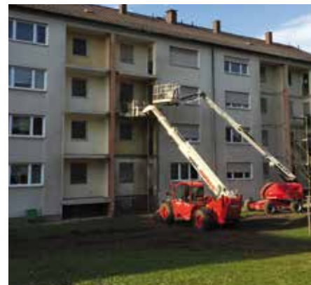
Abbruch der alten Balkone im Finkenschlag
