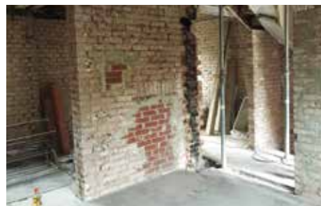
Blick in die Heimgartenstr. 2 im entkernten Zustand
