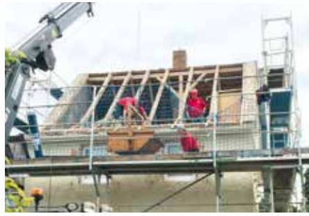
Dacherneuerung in der Damaschkestraße
