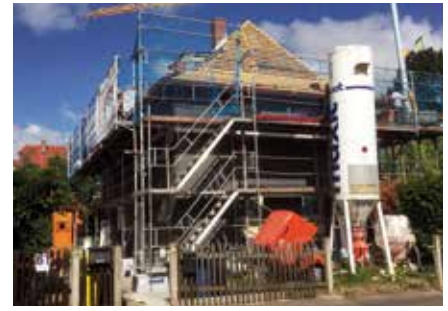
Anbringung der Wärmedämmung in der Damaschkestraße
