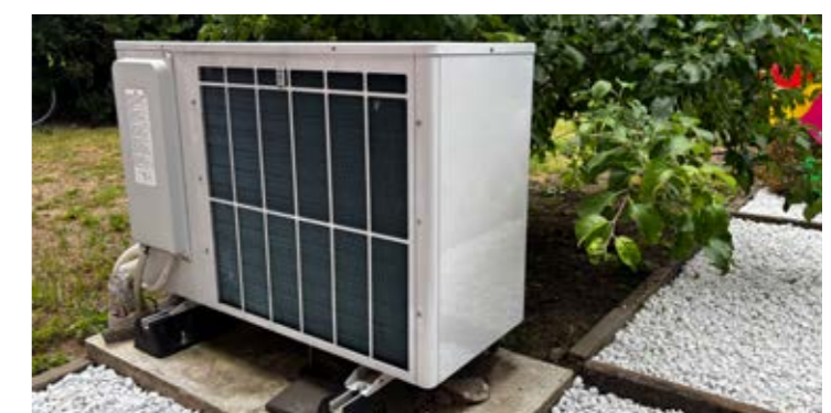
Wärmepumpe für modernisiertes Einfamilienhaus
